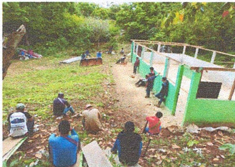
Foto1: Inicio de trabajos de remozamiento de escuela.
