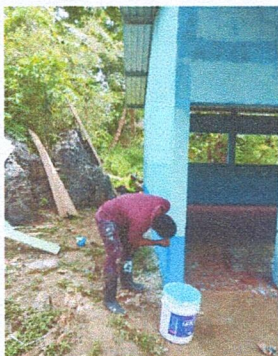
Foto 5: Aplicación de pintura a paredes exteriores.
