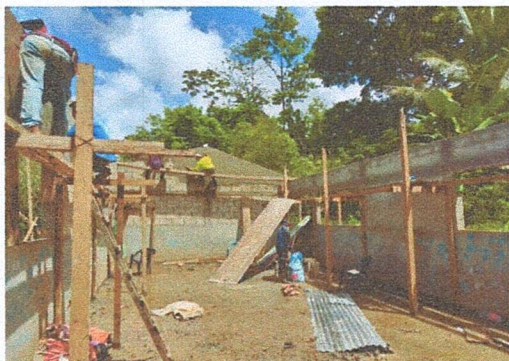
Foto 3: Recubrimiento de las paredes internas del aula.
