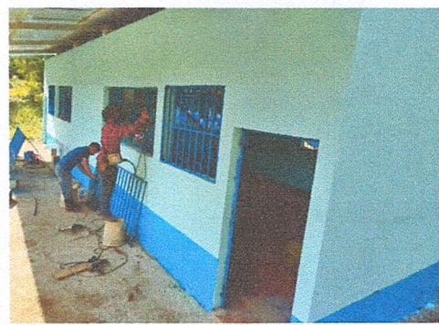
Foto: Instalacion de Puertas y Ventanas.
